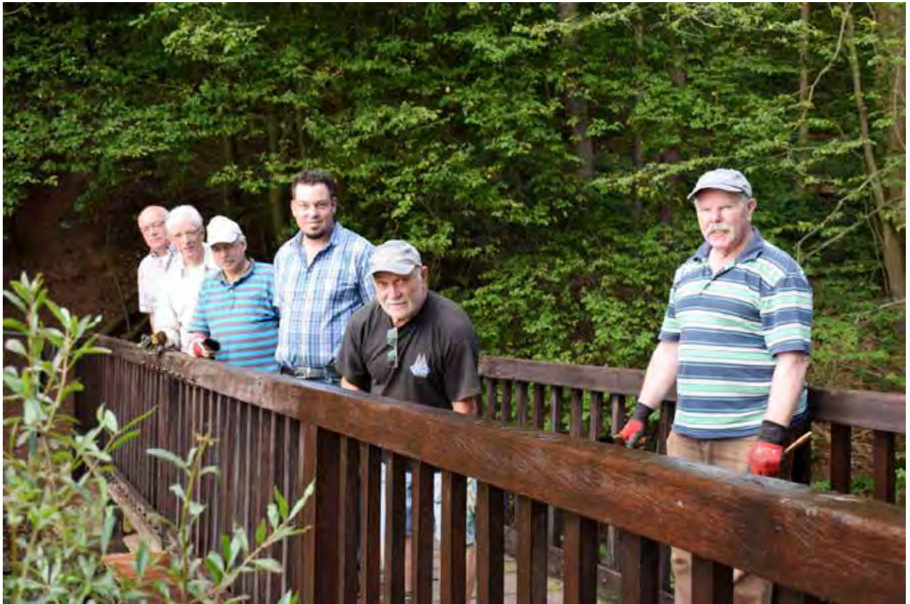
Hand in Hand arbeiten die Männer vom Gartenbau- und Verschönerungsverein Kommern und die Mitarbeiter des städtischen Bauhofs zusammen, um die Holzbrücke am Mühlensee zu sanieren. Foto: Kirsten Röder/pp/Agentur ProfiPress
